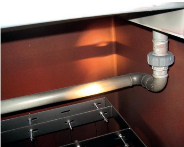
COROFLAKE Beschichtung in einem Nasselektrofilter
