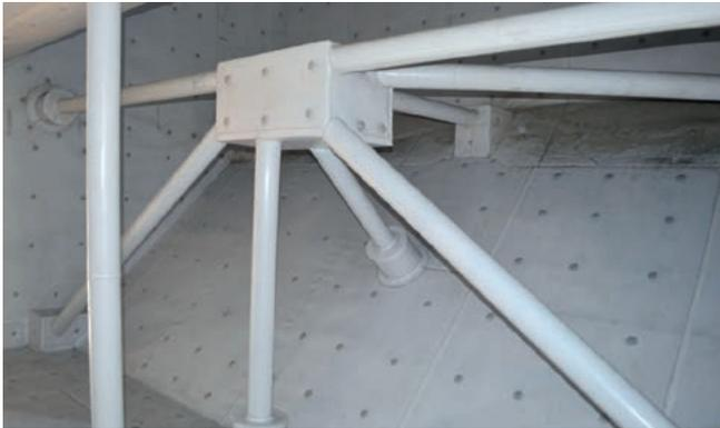
PFA Auskleidung in einem Rohgaskanal
