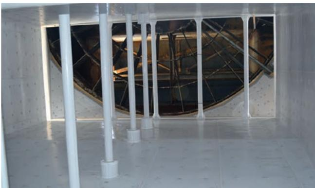
PFA Auskleidung in einem Rohgaskanal
