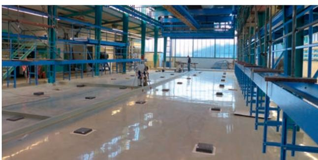
WHG Beschichtung eines Auffangraums in einem Galvanikbetrieb
