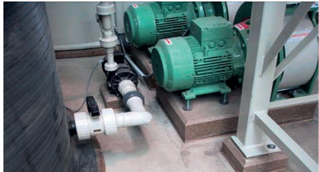
Polybetonsteine als Pumpen- und Apparatefundament
